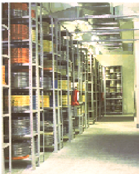
Bóvedas de la Cineteca Nacional
