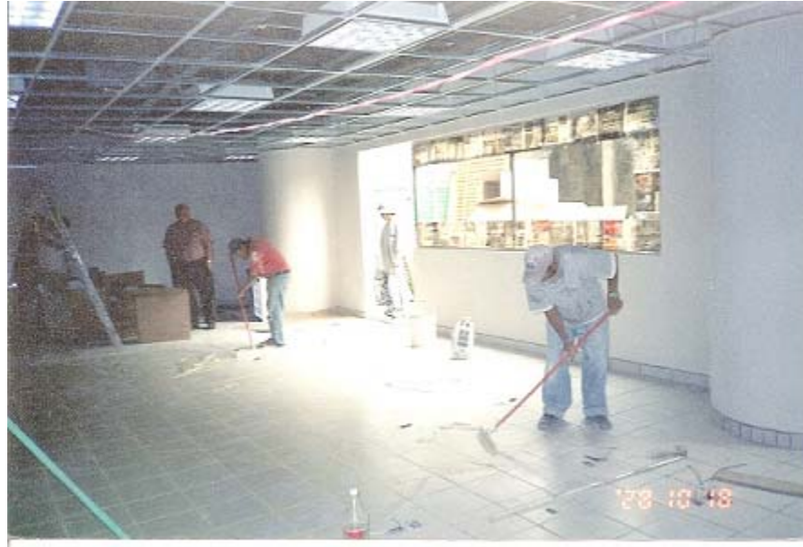
Foto 4 En esta etapa se planifica y se modela el edificio, determinándose que acabados va a tener para dar un estilo y comodidad situando los espacios interiores dentro de este. Edificio en obra- remodelación del Centro de Formación e Innovación Educativa (CEFIE) del Instituto Politécnico Nacional.
