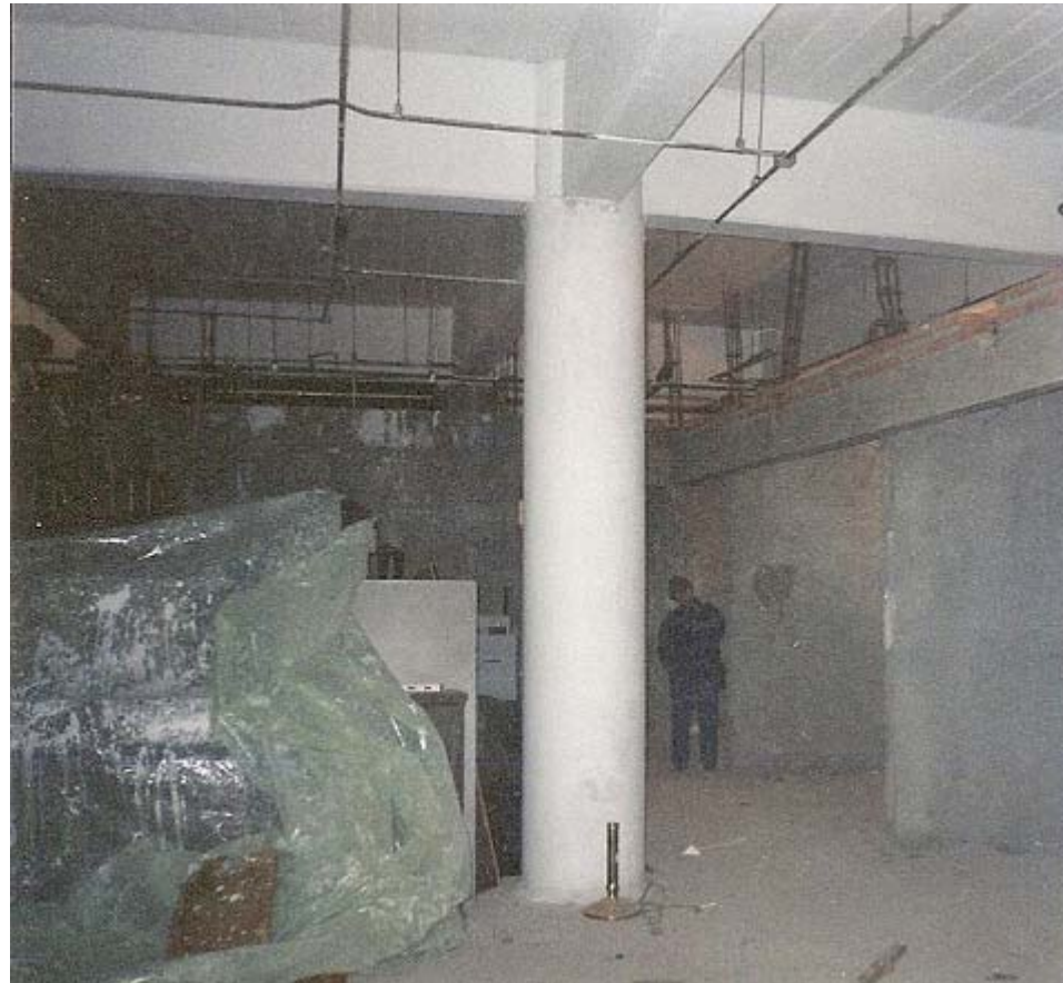
Foto 3 La estructura van a ser los soportes que van a detener al edificio en construcción. Edificio en obra- remodelación del Centro de Formación e Innovación Educativa (CEFIE) del Instituto Politécnico Nacional.
