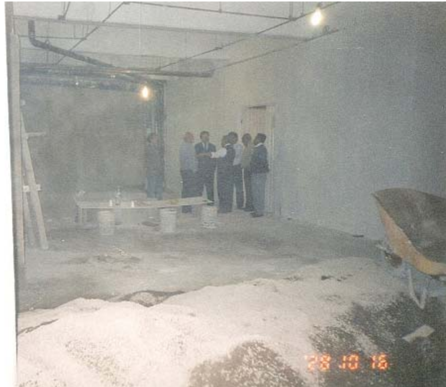
Foto 2 Los cimientos son una obra de la albañilería o cantería que permiten sustentar los muros y soportes de un edificio y que llegan a nivel de suelo. Fotografía de los cimientos del edificio en obra- remodelación del Centro de Formación e Innovación Educativa (CEFIE) del Instituto Politécnico Nacional
